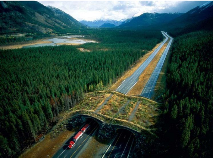
Abbildung 5: Abbildung einer Grünbrücke. Quelle: #Urbanatures blog, Lumberjack (07-06-2018)
