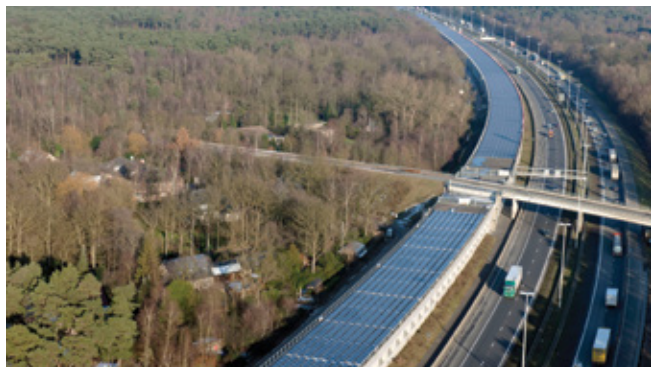
Figura 24: Tunnel "solare" installato nei pressi di Anversa a copertura dei binari ferroviari.
