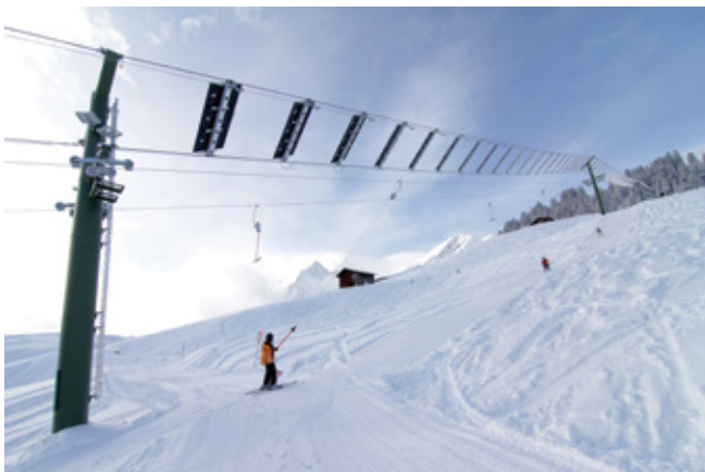
Figure 27: A sinistra, impianto di risalita fotovoltaico installato nella località Walzer di Tenna, nel cantone dei Grigioni, in Svizzera. Fonte: Solarskiift Tenna. A destra, installazione fotovoltaica su struttura paravalanghe, comune di Saint Antönien, Svizzera. Fonte: energiebüro® Zürich - Leading Swiss PV Engineers.
