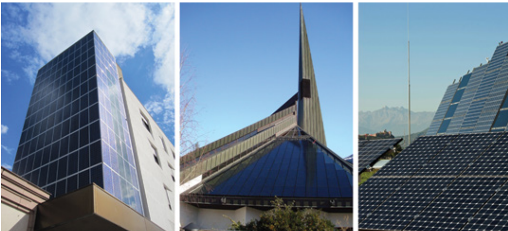
Figura 11: Impianto su facciata (ex-Poste), su falda (Chiesa di Milland) e a campo aperto (ABD)
