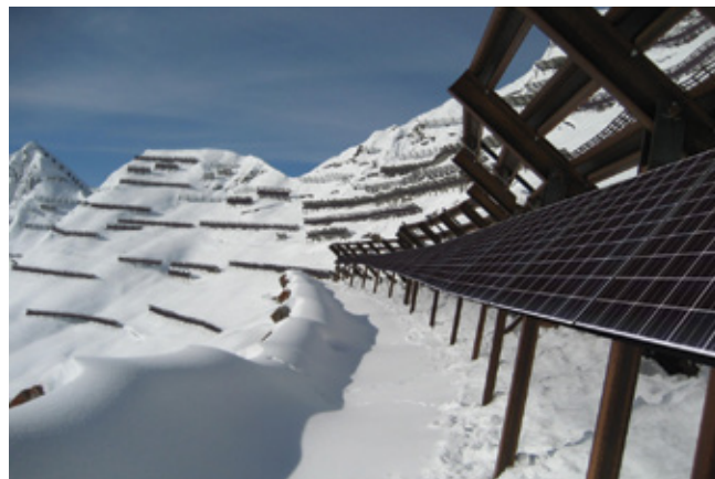
Figure 27: A sinistra, impianto di risalita fotovoltaico installato nella località Walzer di Tenna, nel cantone dei Grigioni, in Svizzera. Fonte: Solarskiift Tenna. A destra, installazione fotovoltaica su struttura paravalanghe, comune di Saint Antönien, Svizzera. Fonte: energiebüro® Zürich - Leading Swiss PV Engineers.
