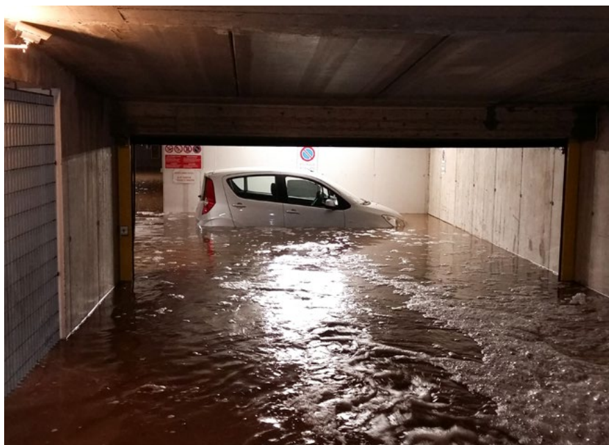
📍 A Bolzano, a causa della pioggia intensa, nella notte tra il 13 e il 14 luglio 2017 molti garage e scantinati si sono allagati.
