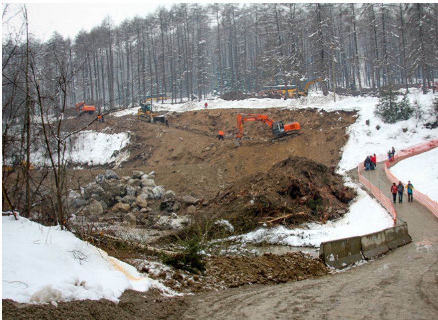
❏ Januar 2014: Ein Steinschlag und Rutschung blockieren die Staatsstraße von Schluderns nach Taufers im Münstertal.
