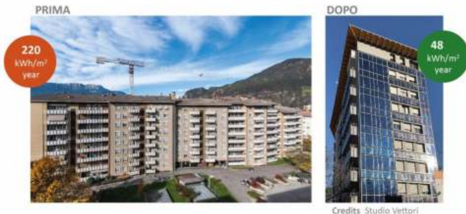
Figura 5: quartiere via Cagliari/Brescia. Fonte: Progetto Sinfonia
