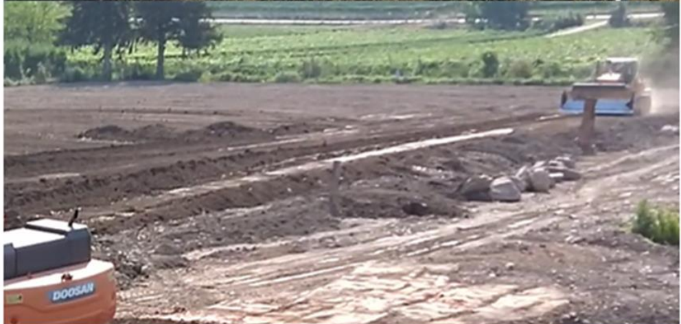
Fläche nach erfolgter Auffüllung der Grube und erneuter Erdbedeckung.
