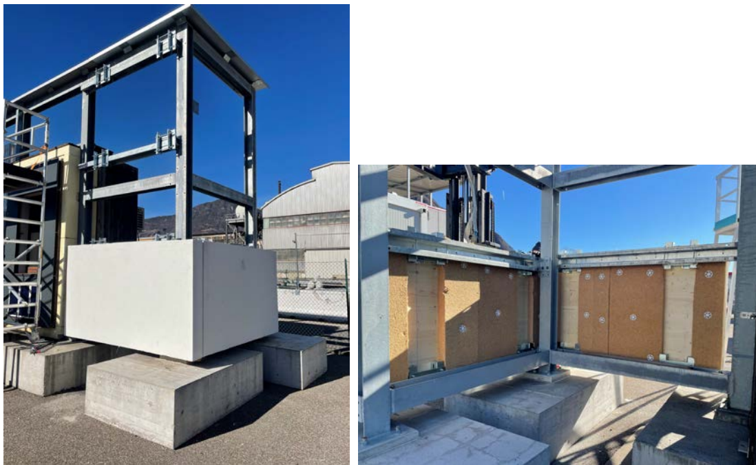
Figura 48: Installazione pannelli - configurazione angolo - Prova II
