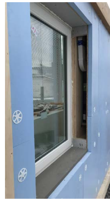
Figura 5: Vano per ispezione della macchina
