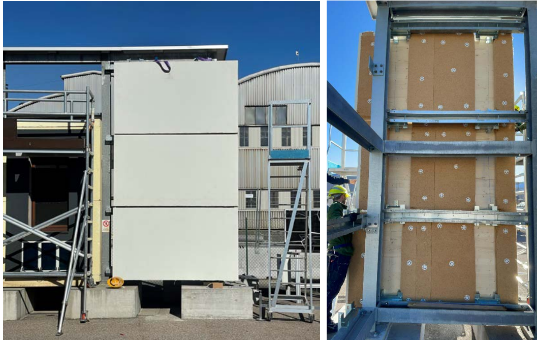
Figura 47: Installazione pannelli- configurazione frontale- Prova I
