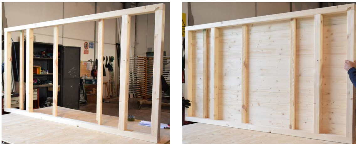
Figura 10: Struttura portante dei pannelli
