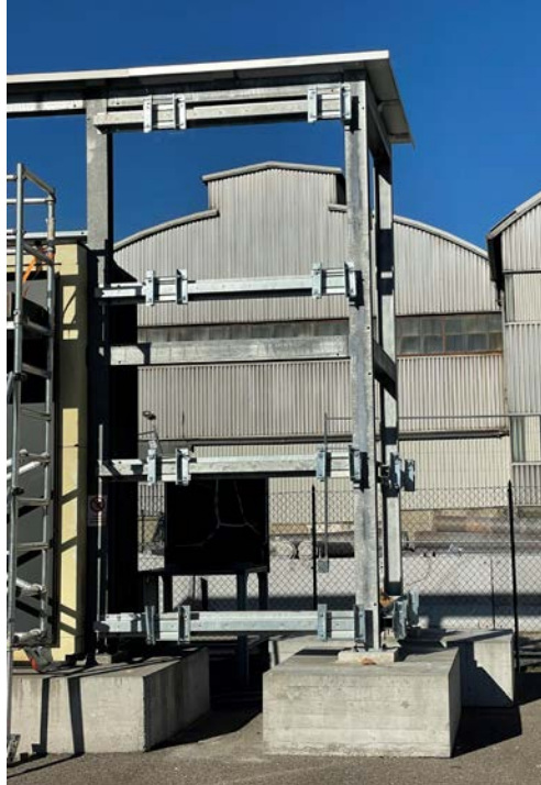
Figura 41: Posizione ancoraggi Flexilab
