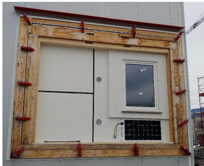
Figura 14: Pannello prototipo con sistemi integrati
