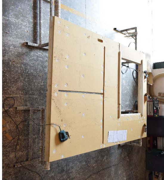
Figura 13: Composizione pannello – Giunti
