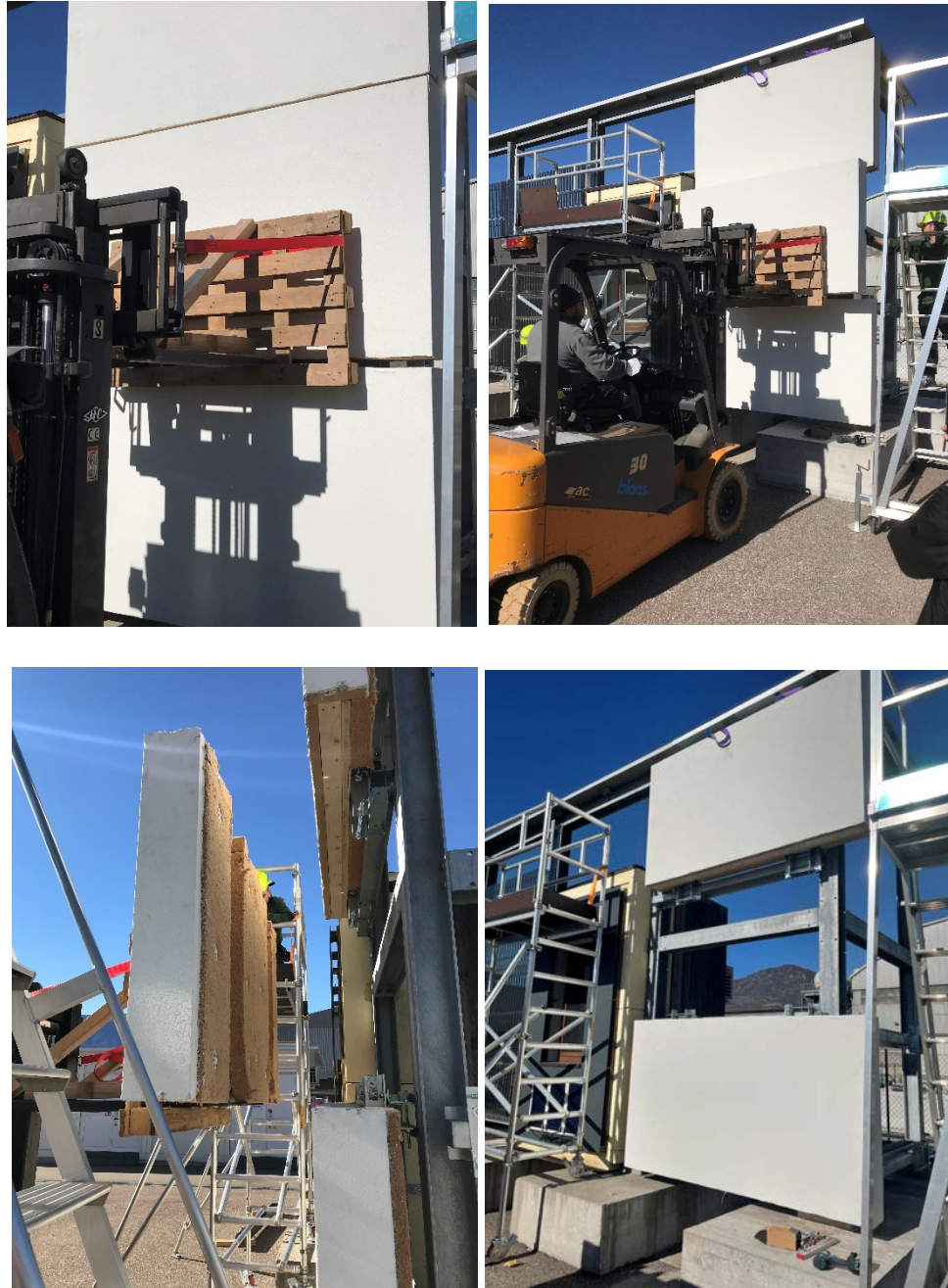
Figura 49: Fasi di smontaggio pannello centrale
