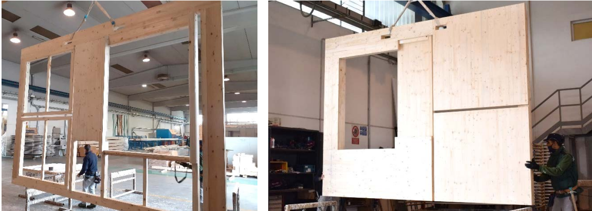
Figura 11: Struttura portante prototipo facciata integrata
