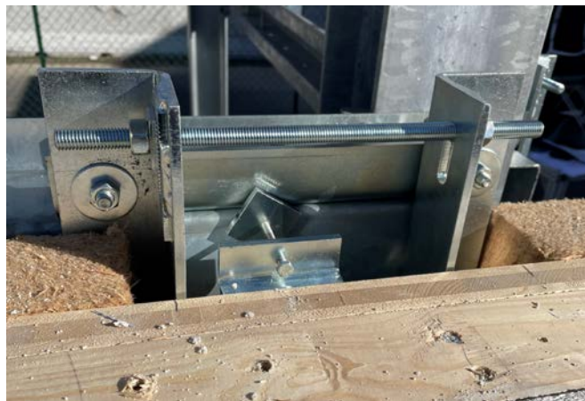
Figura 46: Regolazione distanziatore
