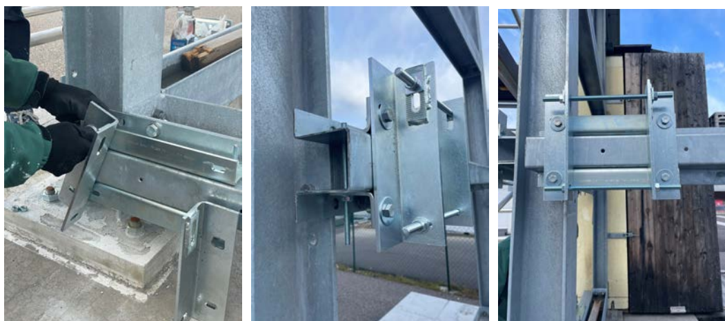
Figura 40: Posizione ancoraggi
