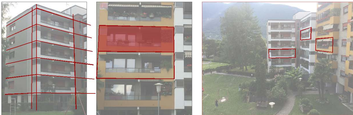
Figura 9 Prime stime di scomposizione dei prospetti in fase di ispezione dell'edificio
