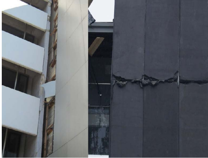
Figura 34: Danneggiamento pannelli di rivestimento leggeri (Fonte: Barid, 2014)
