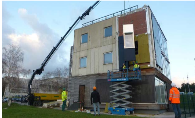
Figura 25: Installazione moduli di facciata (Fonte: www.renozeb.eu )
