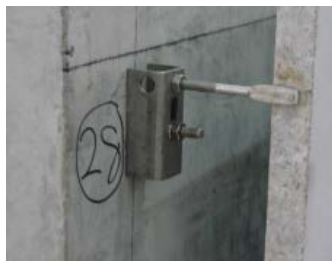
Figura 41: Connessione a Tassello-Perno (Fonte: Huang B., 2020)
