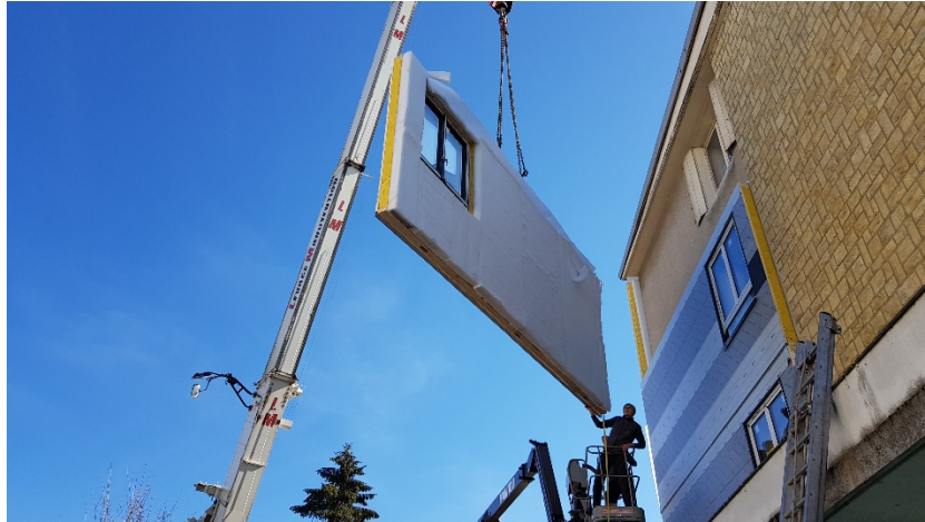
Figura 31: Posa di una parete in CLT. Fonte: Bertim
