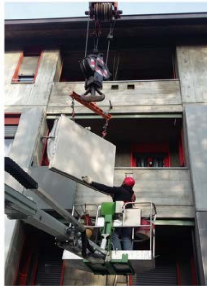
Figura 18: Installazione Pannelli (Fonte: P2Endure)
