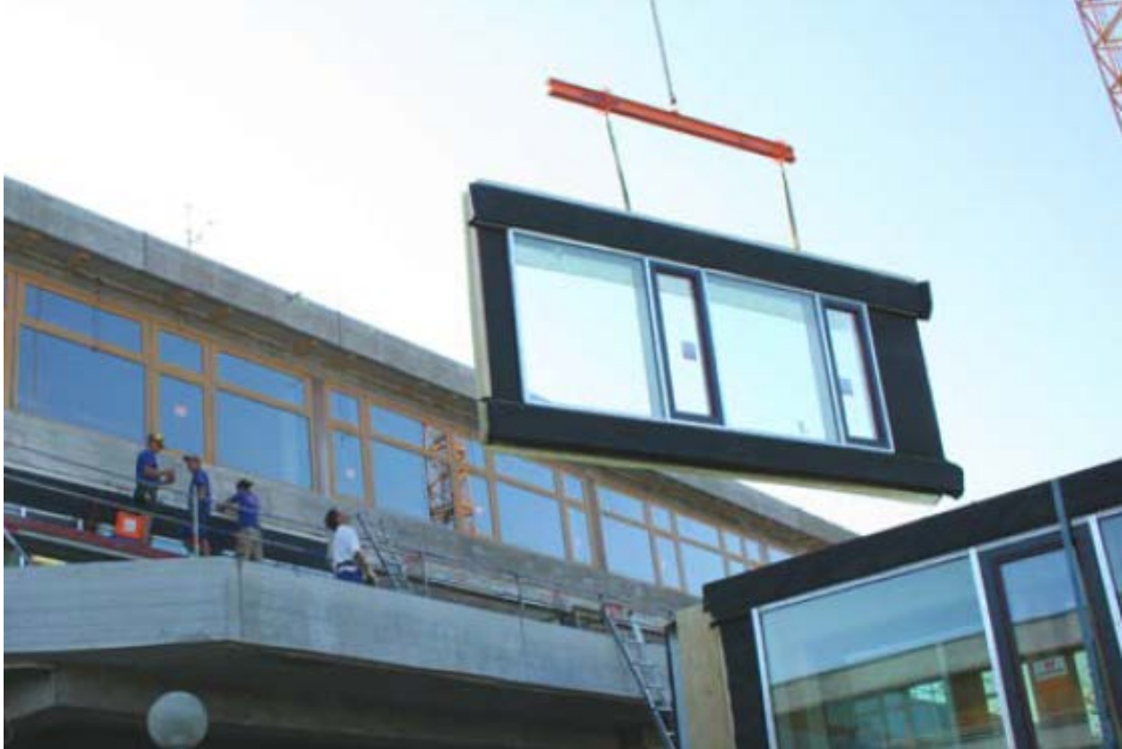
Figura 3 Montaggio di una parete. Fonte: TES Energy Façade
