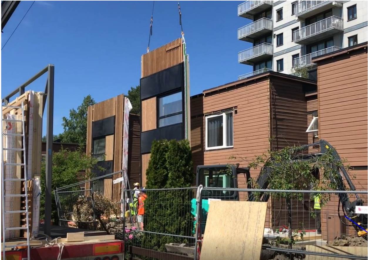
Figura 19 Installazione delle pareti ad Oslo. Fonte: 4RinEu
