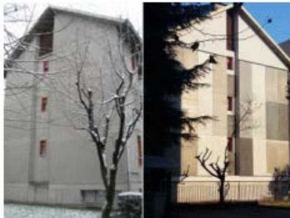
Figura 15: Demo Italiano Pre e Post Retrofit (Fonte: www.p2endure-project.eu )
