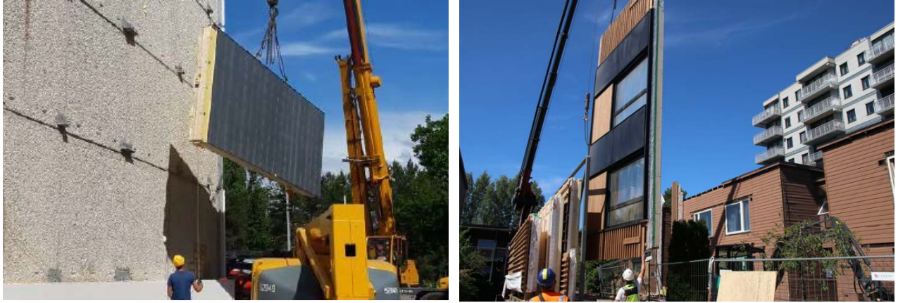
Figura 21: Installazione dei pannelli, a sinistra il progetto More-Connect, a destra 4RinEU. Fonti: more-connect e 4RinEU
