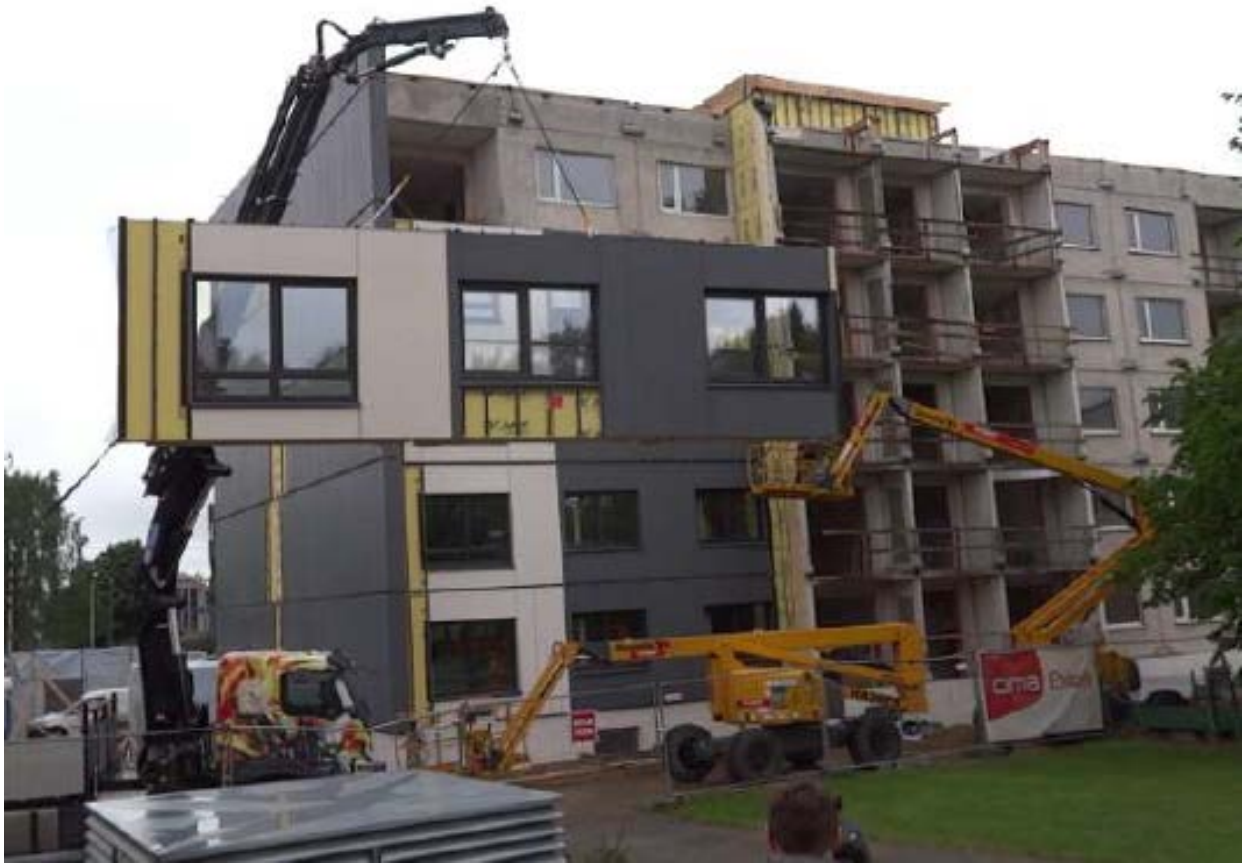
Figura 10 Installazione della parete in cantiere. Fonte: More-Connect
