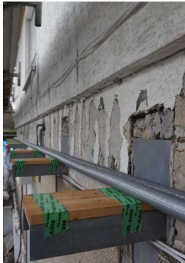
Figura 24: Ancoraggio di base in acciaio
