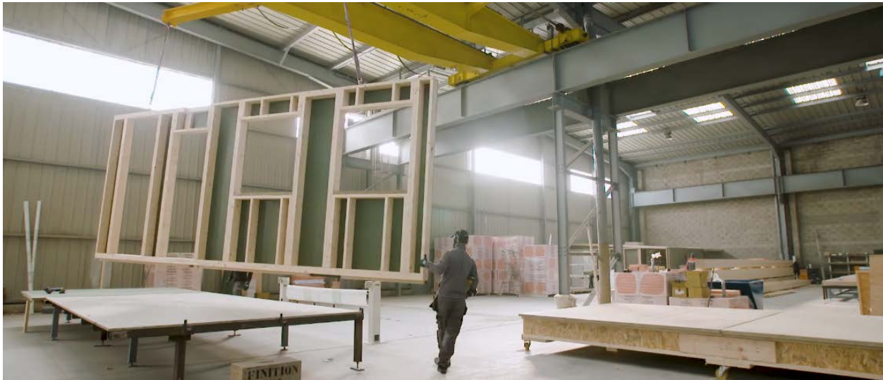
Figura 7 Prefabbricazione della parete in officina. Fonte: NWeurope.eu
