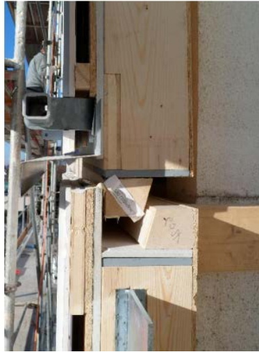
Figura 23: Fissaggio degli elementi nella trave di ancoraggio
