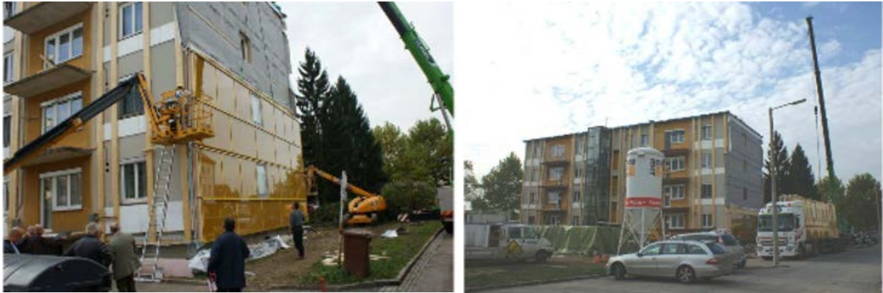
Figura 32 Installazione di pannelli prefabbricati nel progetto GAP. Fonte: AEE INTEC
