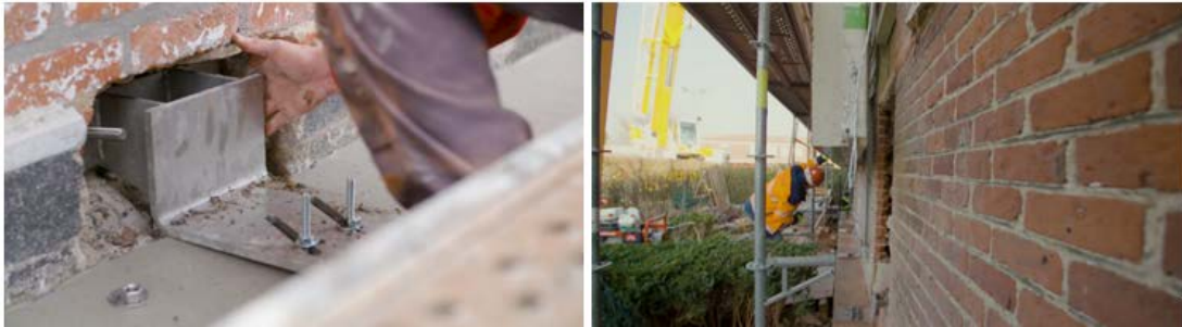
Figura 8: Ancoraggio (sx) e installazione (dx) moduli di facciata (Fonte: renovation-hub.eu)
