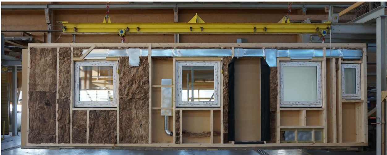
Figura 9 Parete prefabbricata in officina. Fonte: Gumpp & Maier GmbH
