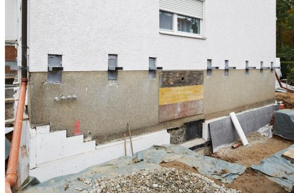
Figura 7: : Sistemi di aggancio alla struttura esistente. A sinistra, il progetto iNSPIRe (© G&M), a destra le connessioni installate con per in Energiesprong FR (© nweurope.eu).
