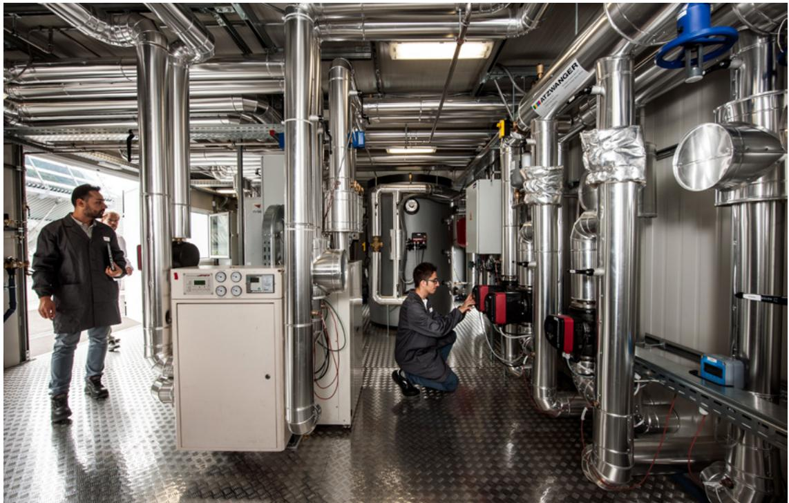
Das Energy Exchange Lab im NOI Techpark, eine neue Infrastruktur für **Tests an Fernwärme- und Fernkühlungssystemen**, gehört zu den wenigen in Europa, die ein komplettes Fernwärmennetz von der Energieproduktion bis zum Endverbrauch nachbilden. (Foto: Ivo Corrà)
