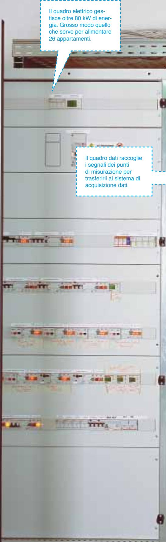
Il quadro dati raccoglie i segnali dei punti di misurazione per trasferirli al sistema di acquisizione dati.
