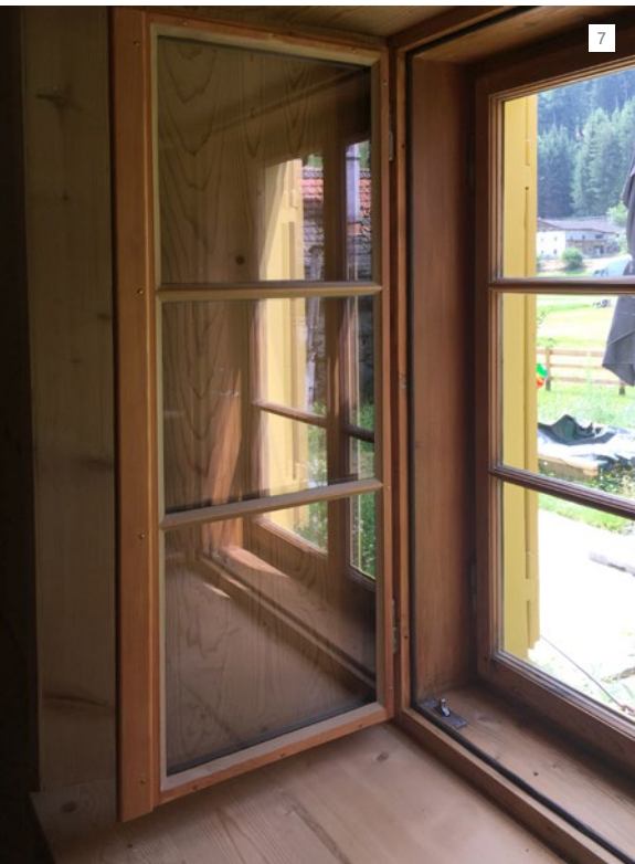
6. Außenansicht Fenster Sanierung
