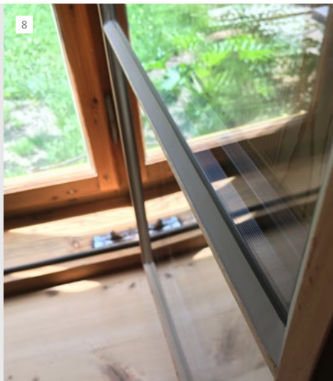
7. Innenansicht Fenster Sanierung mit offenen Innenflügeln
