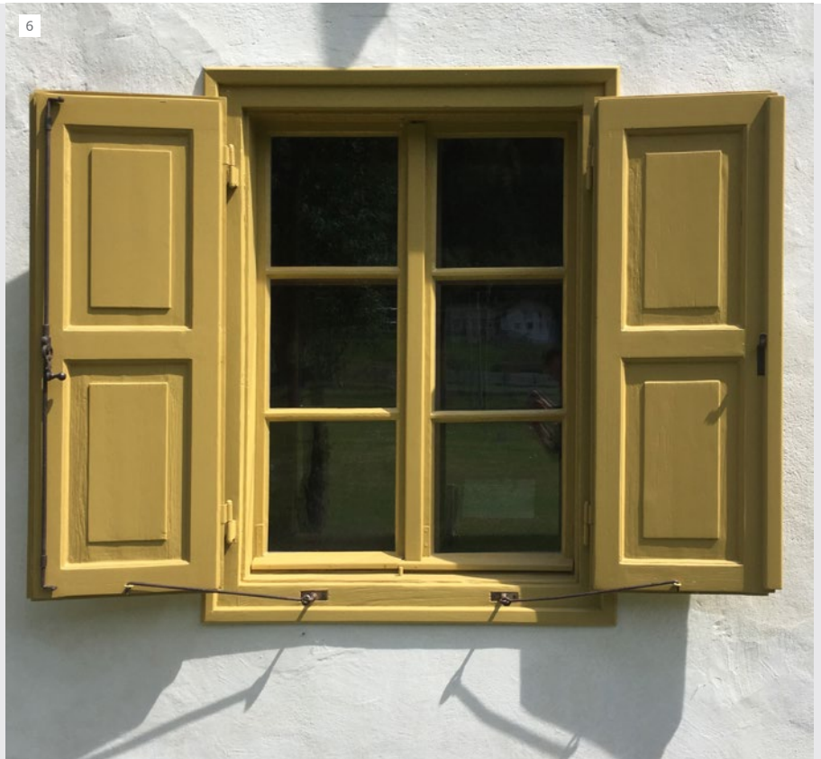
5. Innenansicht Fenster Sanierung
