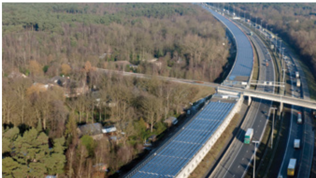
Abbildung 24: „Solar“-Tunnel als Gleisabdeckung bei Antwerpen.
