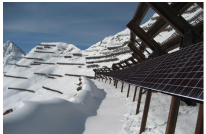
Abbildung 27: Links der Solarskiflift Tenna im Schweizer Kanton Graubünden. Quelle: Solarskiflift Tenna. Rechts PV-Anlage auf Lawenschuttschneefangmauer, Gemeinde Saint Antönien, Graubünden, Schweiz.
