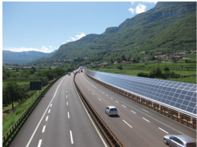
Abbildung 25: Photovoltaik-Schallschutzwand an der Brennerautobahn bei Isera
